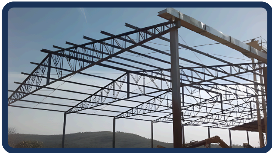
Pintura em Pilares e Estruturas Metálicas
