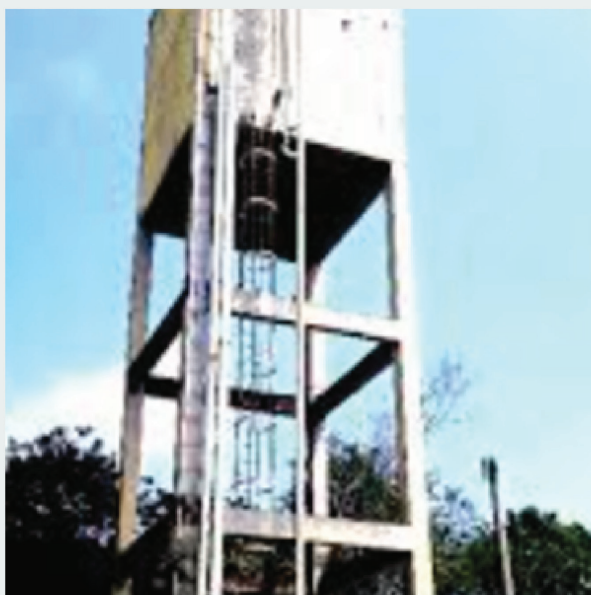
Elevado Em Concreto Armado
