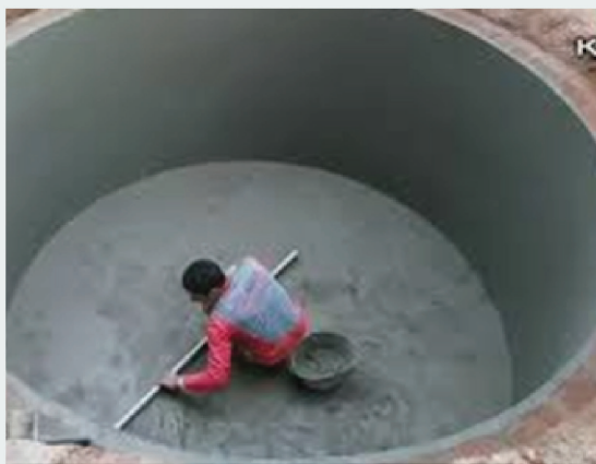
Cisterna de Concreto / Alvenaria
