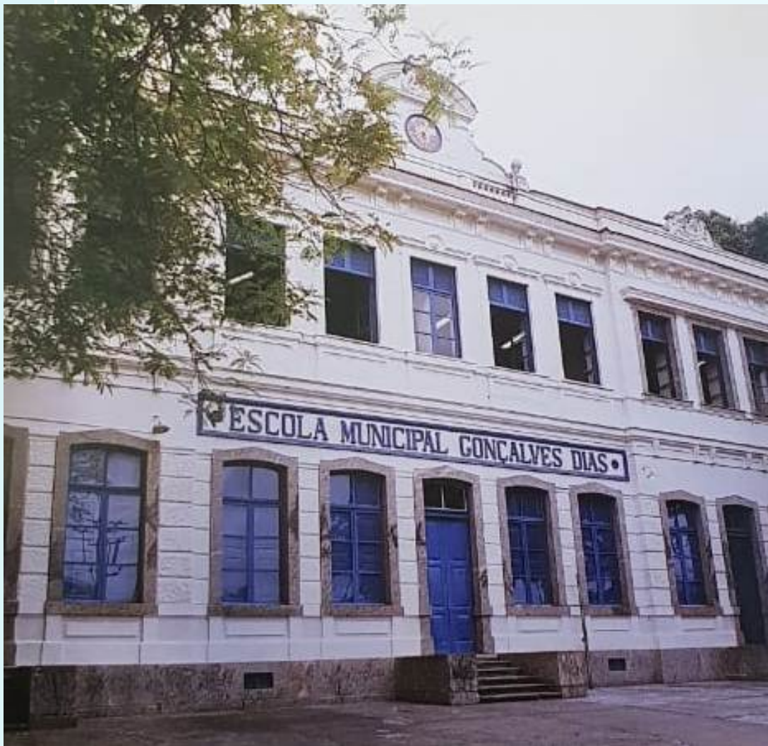
Escola Municipal Gonçalves Dias, localizada em São Cristóvão.
